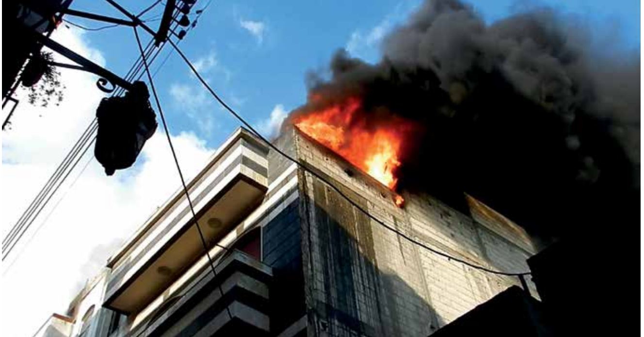
בניין בחמץ עולה באש כתוצאה מהפצצות של חיל האוויר הסורי, 25 בפברואר 2012. מאפיין חשוב של קרבות עירוניים מן העבר הוא קיומם של קרבות זעירים שניטשו על סוגיית השליטה במבנים אלה. צילום: ויקיפדיה
