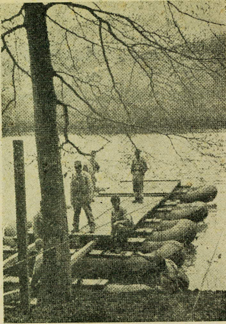
התקנת גשר קל על גבי מצופים (סירות פנויחטיות)
