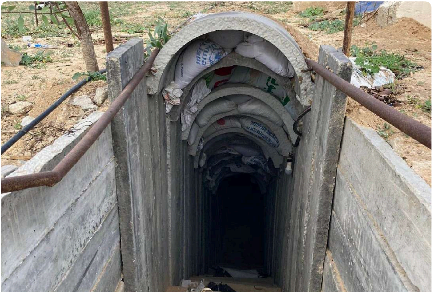
פיר מנהרה במחנה הפליטים אל־בורייג' במרכז רצועת עזה. החלק העליון מדופן בשקי סיוע של אונר"א וממשלת יפן. צילום: דובר צה"ל
