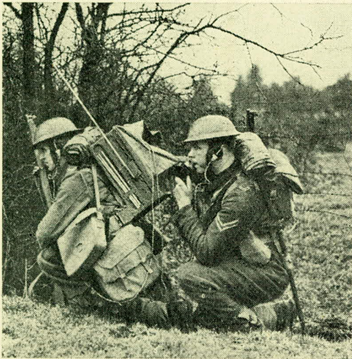
מערכת אלחוט מטלטלת, לשידור והאזנה „מס“ 384, הנהוג ביחידות הרגלים בצבא הבריטי.
