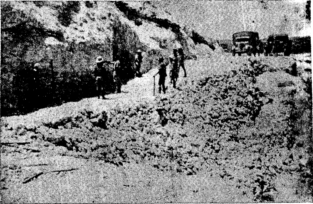
מראה ה"הריסה הרבתי" בכביש החוף, מדרום לאסכדרון שעה שהגיע למקום הבריגי סטיבנס
