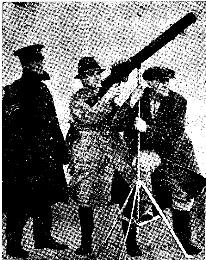
מקלע "לואיס", נשק חיל הרגלים לשעבר. כיום מצויד בו "משמר המולדת" הבריטי. על הצובה מיוחדת משמש להגנה אנטי-מטוסית.
