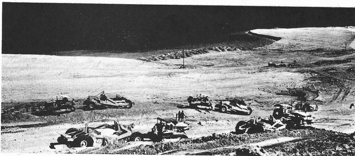
עבודות העפר בנמל החדש. בתמונה: טרקטורים ודחפורים גורפים את הגבעות הסמוכות כדי ליבש את המפרץ הנראה לעין.
