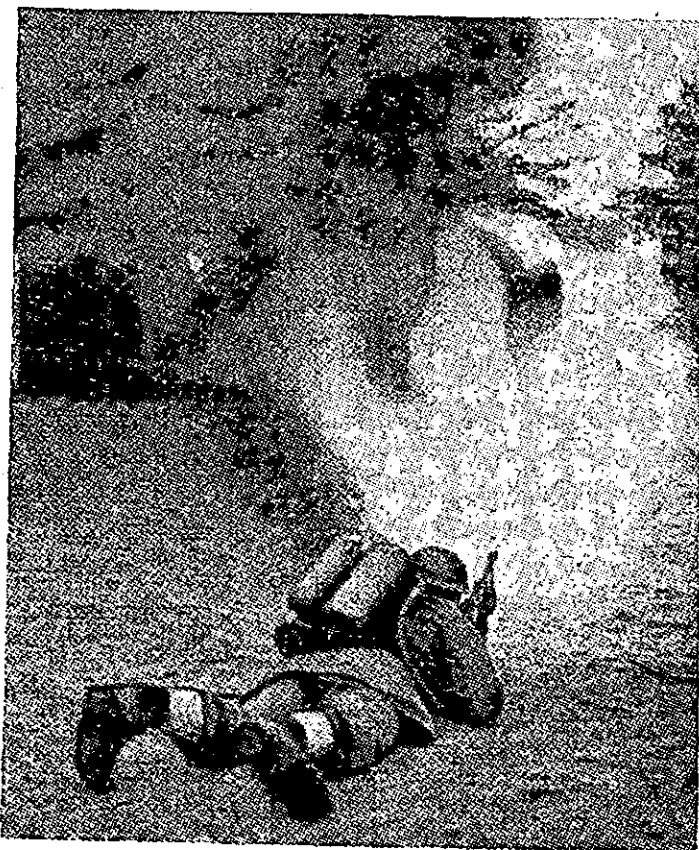
זורק-אש (צבא ארצה"ב) בעת פעולה. על גבו שני מיכלי-הדלק והמיכל, הקטן יותר, לגז דחוס. שים לב להתפשטות הלהבה בעת היתקלה בעמדת-הבטון.
