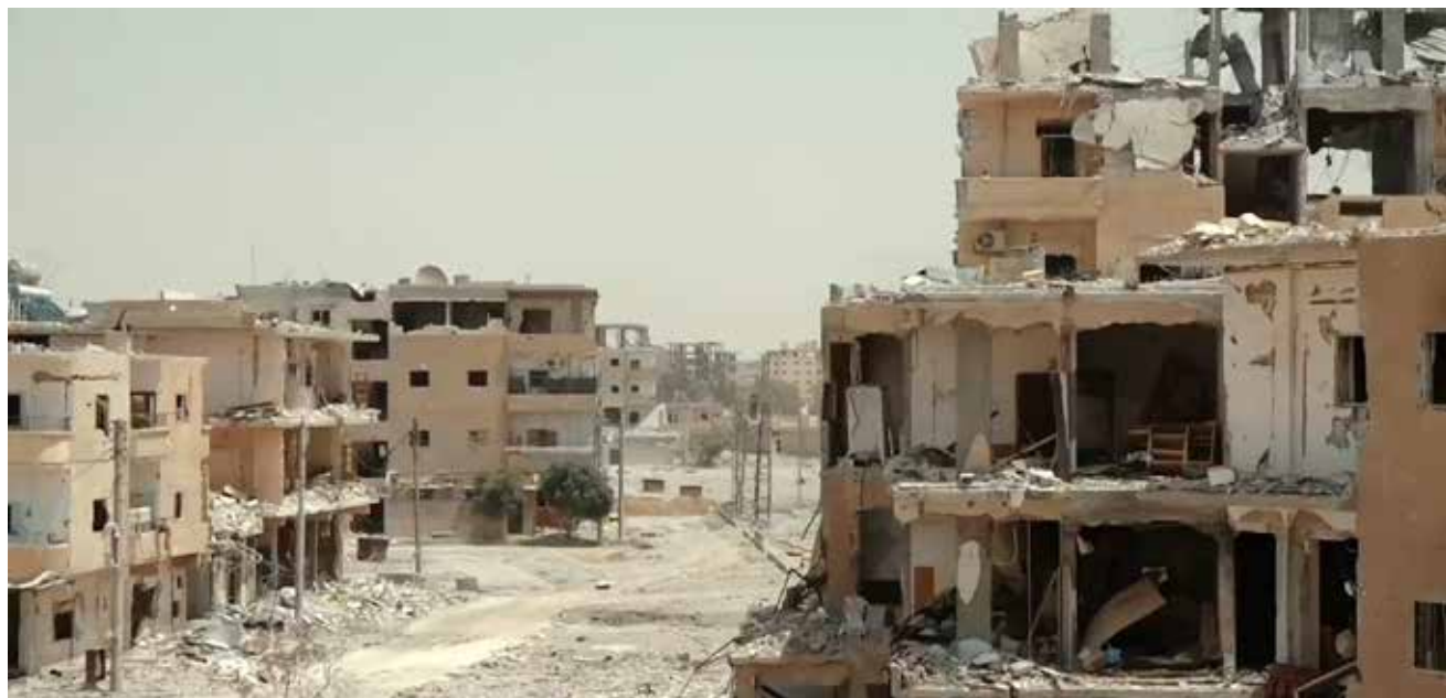
בניין הרוס באל-רקה סוריה, יולי 2017. התקפה על עיר - הטומן בחובו עלות גבוהה וסיכון גבוה, יתרחש לעתים קרובות יותר ויותר. צילום: ויקימדיה
