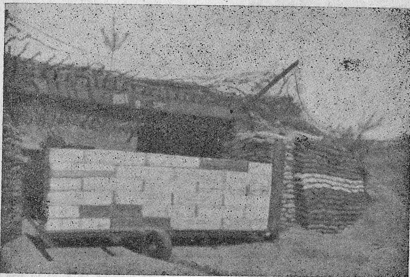
שער-בונקר הסביע-צירו מחפה על הצות בפני התפוצציות שמאחורי הבונקר. שער זה ניתן להפתח תוך שניות ספורות, במקרה של צורך להעתיק את כלי-התותח
