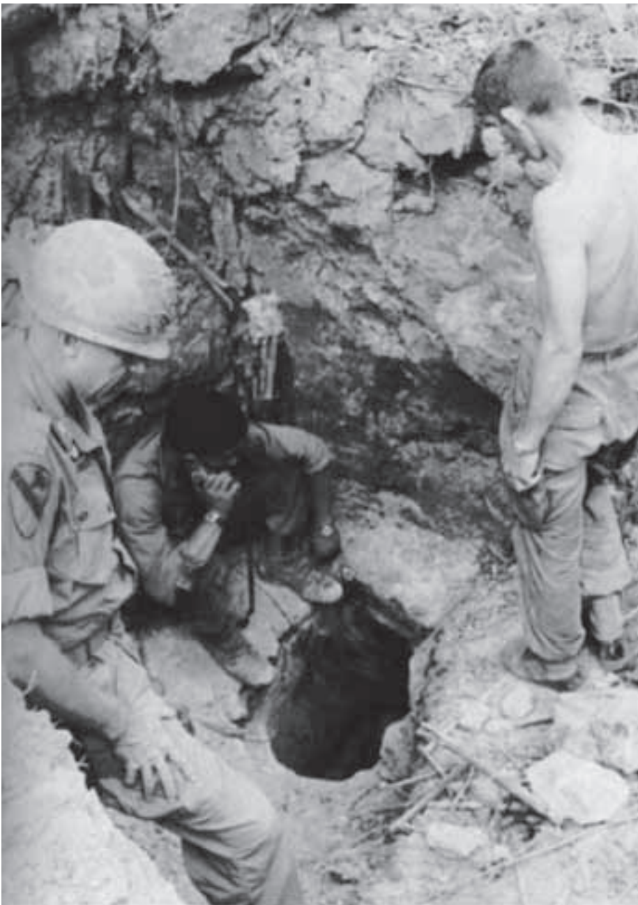
פתח מנהרה שחשפו כוחות אמריקניים | המנהרות פוצצו בדרך כלל באמצעות דחיסת גז אצטילן למערכת המנהרות ופיצוץ
